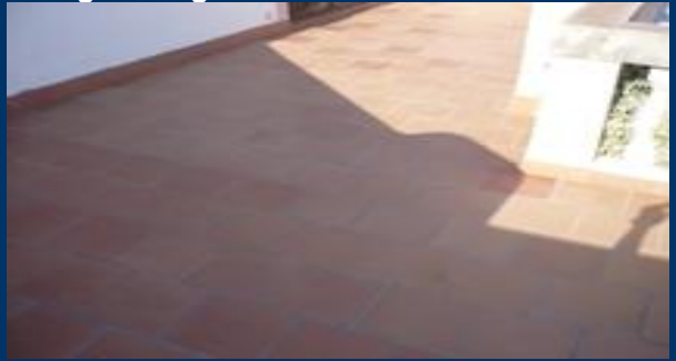
Fertigstellung der Fliesenarbeiten.
