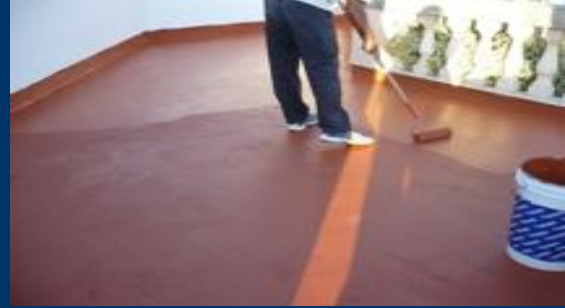
Fertigstellung der 3fachen Abdichtung.
