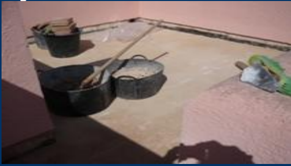
Beginn mit dem Rückbau der alten Fliesen.
