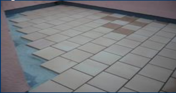
Beginn der Fliesenarbeiten auf der Dachterrasse.
