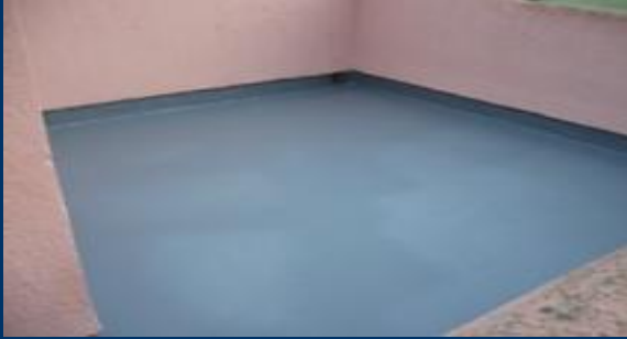
1 Lage Imper Tec der Firma TecnoI aufgetragen.
