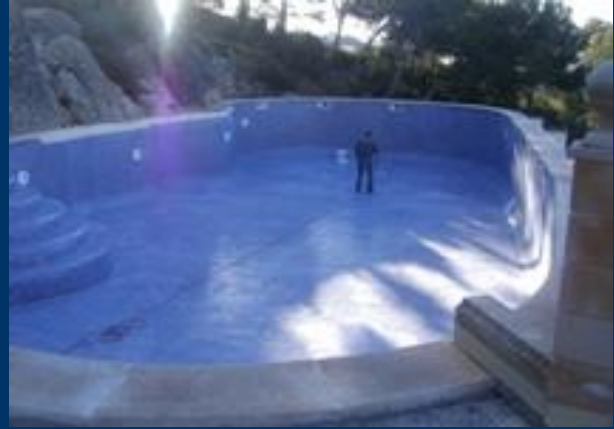
Fertigstellung der Fliesenarbeiten Wand/Boden
