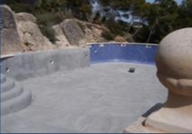
Beginn der Poolfliesenarbeiten im Wandbereich
