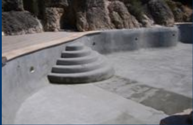
Fertigstellung der Abdichtungsarbeiten des Pools
